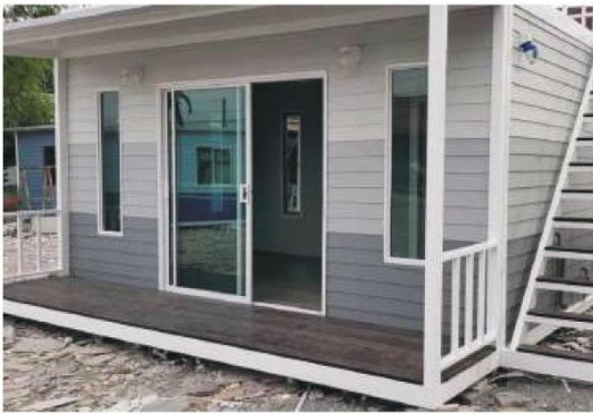
บ้านประกอบเสร็จ
